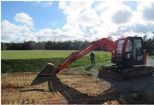
北部訓練場のヘリパッド工事
