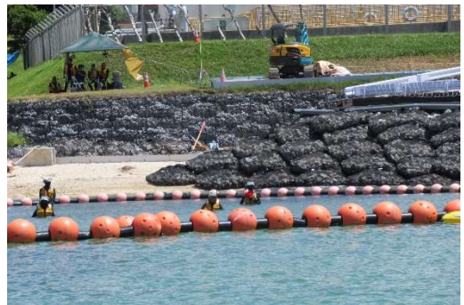
大浦湾から工事現場を見る 7月15日
