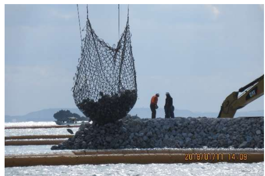
「進む護岸工事」
