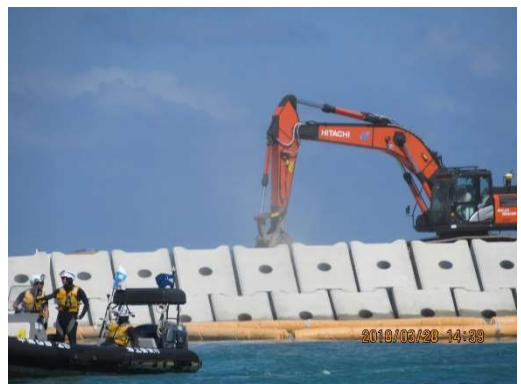
進む護岸工事
