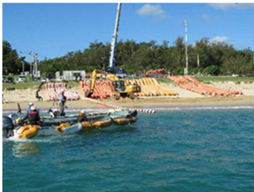
浜に並べられたフロートとオイルフェンス
