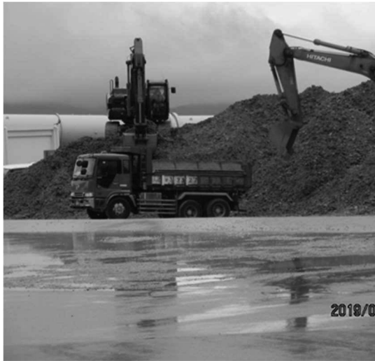
【安和棧橋内の仮置き場の土砂（赤土）】
