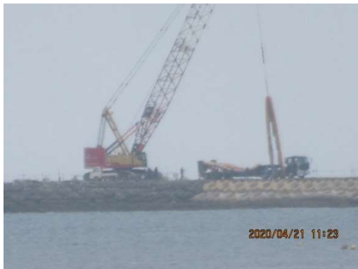
【工事中断でフロートを撤去、K8護岸】
