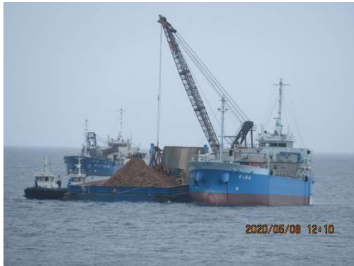
【塩川港沖で土砂の積み替え作業】
