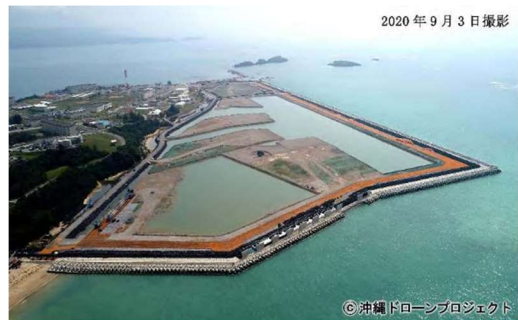
【辺野古の埋め立て状況 2020年9月3日 (沖縄ドローンプロジェクト提供)】
