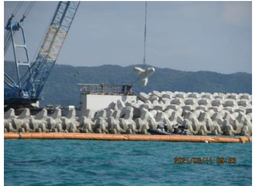
【進む護岸工事】
