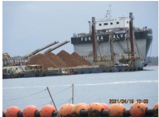
【デッキパージ船から台船への積替え作業】
